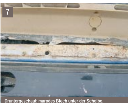
7 Druntergeschaut: marodes Blech unter der Scheibe.
